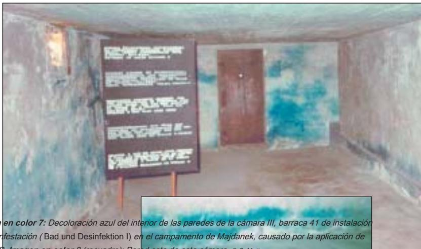
*Imagen en color 7: Decoloración azul del interior de las paredes de la cámara III, barraca 41 de instalación de desinfección (Bad und Desinfektion I) en el campamento de Majdanek, causado por la aplicación de Zyklon B. Imagen en color 8 (recuadro): Pared este de esta cámara. © C. Mattoño*
